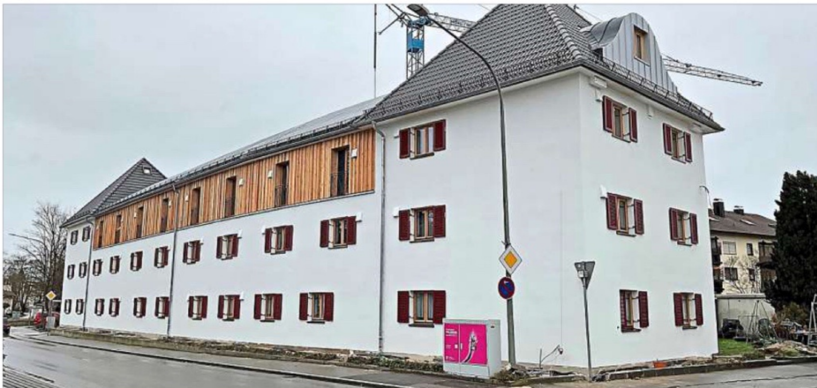
Das Wohnhaus an der Trostberger Straße präsentiert sich - ohne die vielkritisierten Planen.
